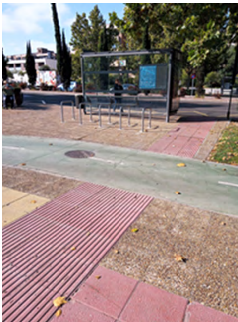
Figura 3. Pavimento direccional interrumpido por carril bici
