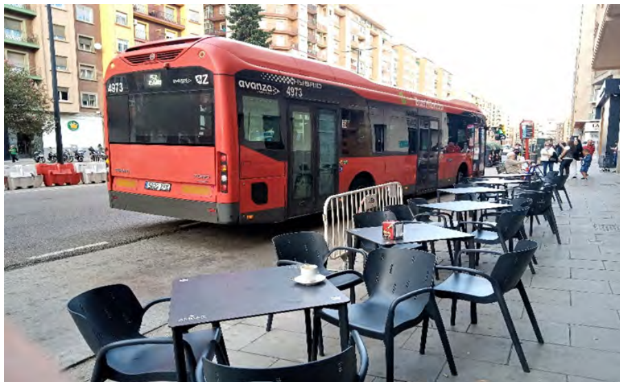
Figura 1. Parada provisional por obras llena de obstáculos
